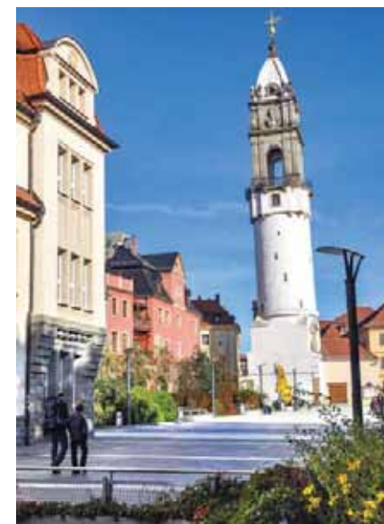
Schiefer Reichturm von Bautzen
