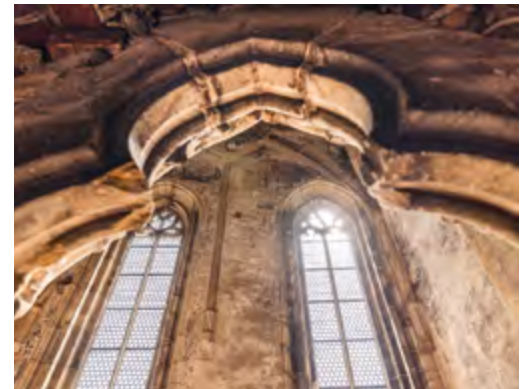
Georgskapelle im Turm
