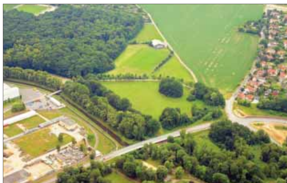
Im September sollen die umfangreichen Baumaßnahmen an der Spree beginnen. Foto: Dietmar Schröder
