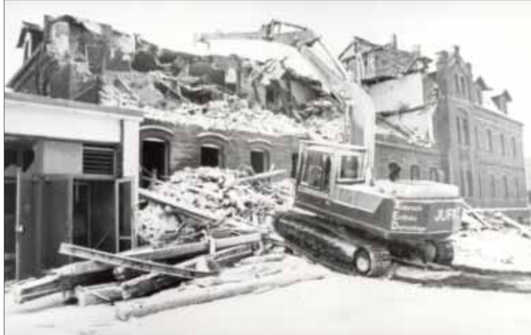
Aus für den Bautzener Schlachthof: das Verwaltungsgebäude während der Abbrucharbeiten.
