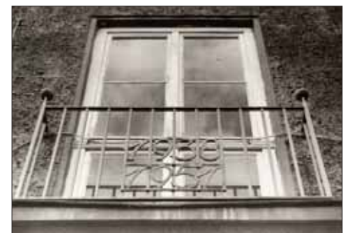
Am Fenster des Verwaltungsgebäudes waren bis 1993 die wichtigen Jahreszahlen zu erkennen.
