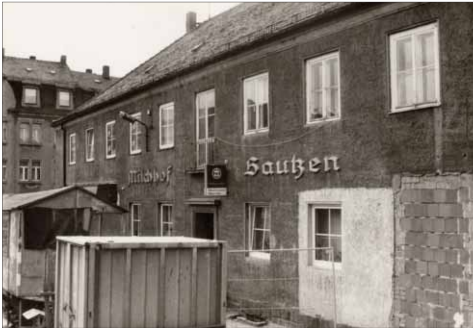
Noch sind die Spuren der Vergangenheit sichtbar: das Hauptgebäude des neuen Milchhofes im September 1993.
