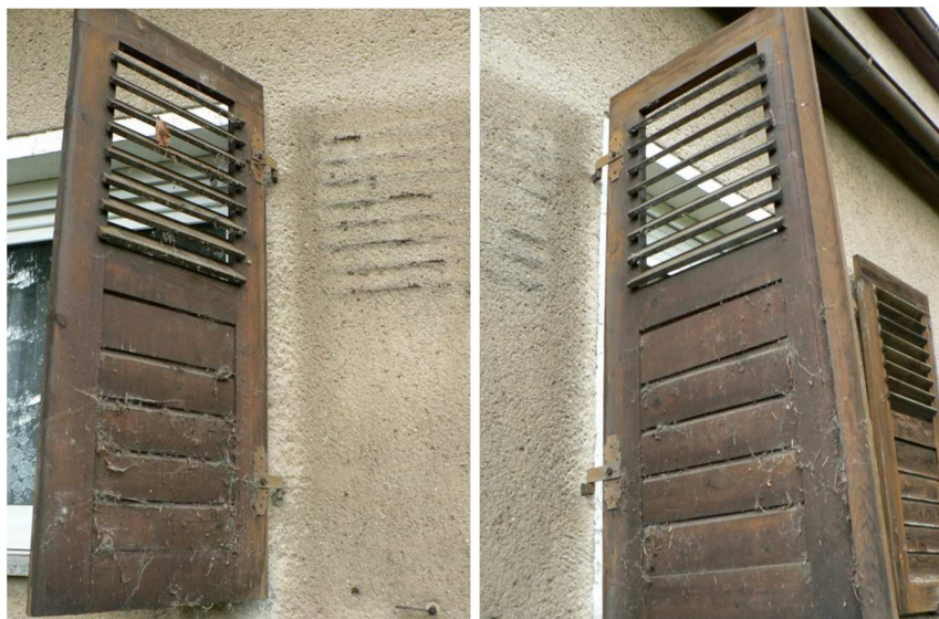
Abbildungen 13: die Fensterläden am Gebäude wurde seit längerer Zeit nicht genutzt; hier können Fledermäuse ein gutes Spaltenquartier finden
